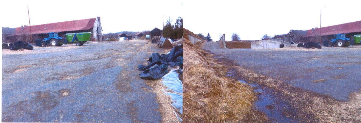
Obr. č.3,4 – Pohled na oceňovaný areál z jihozápadní strany; pohled na severozápadní část oceňovaného areálu z jižní strany
