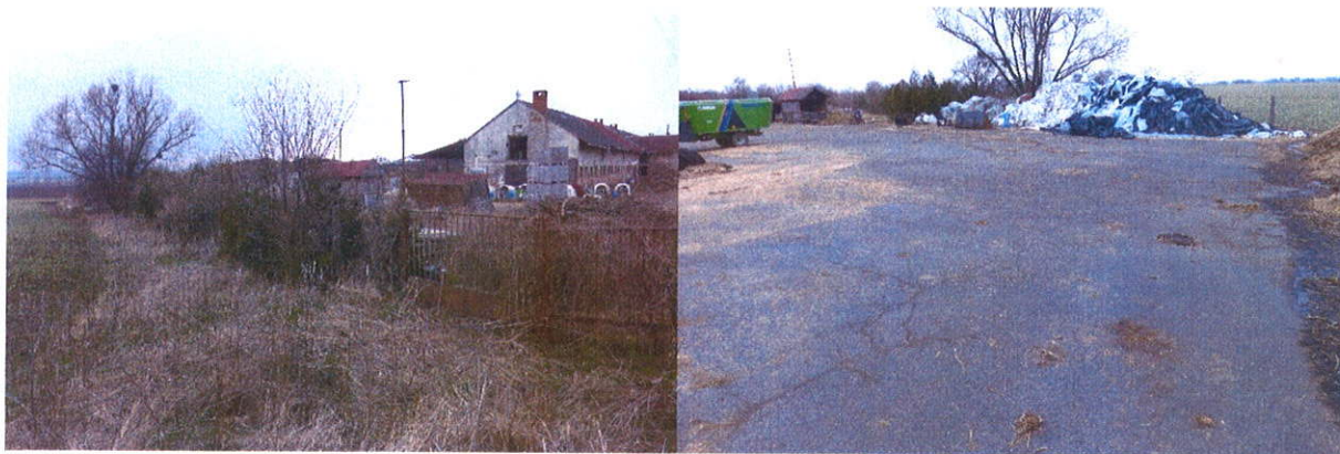
Obr. č.1,2 – Pohled na oceňovaný areál z jižní strany; pohled na západní část oceňovaného areálu ze severní strany
